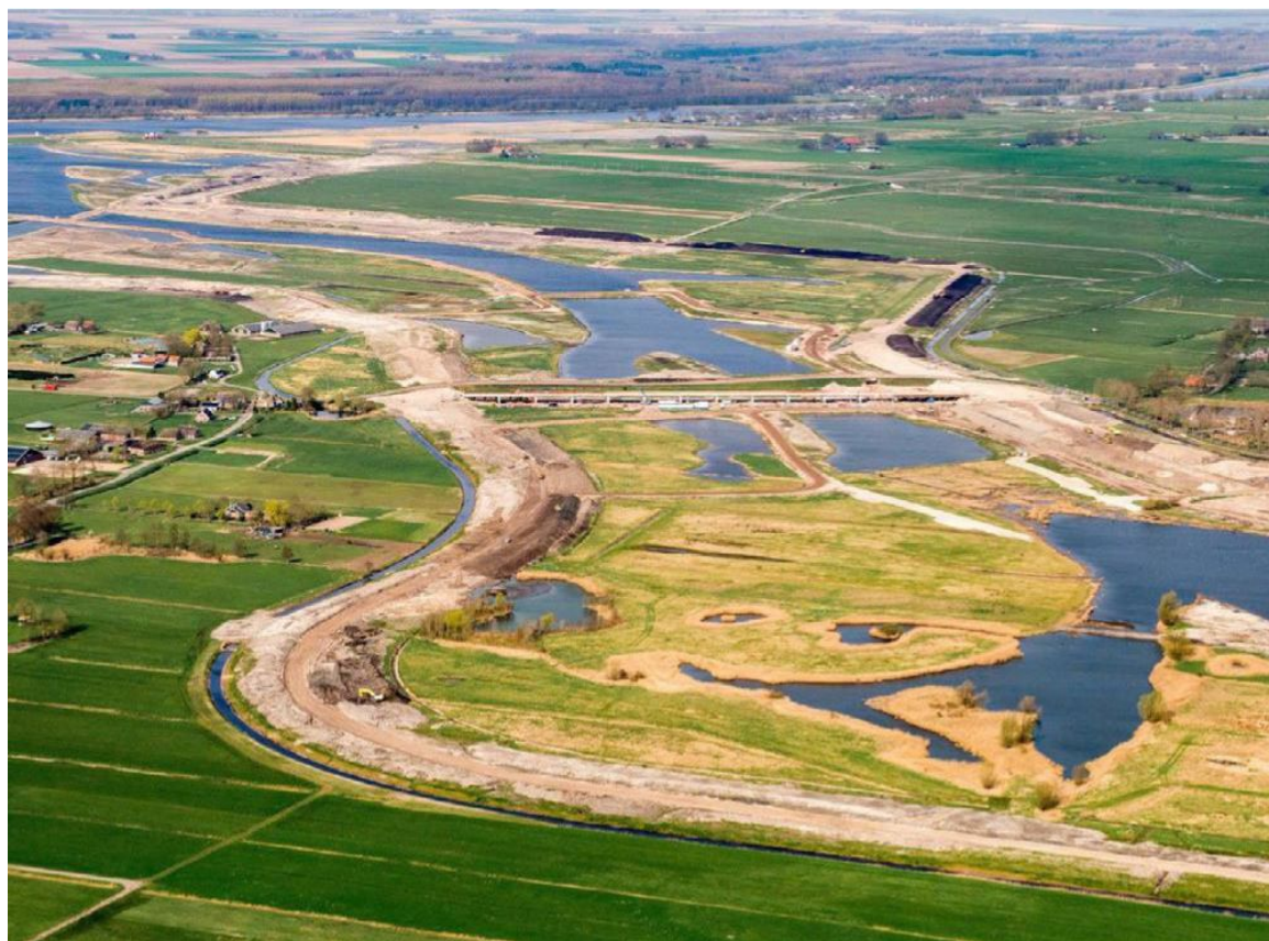
Het Reevediep en de klimaatdijk in aanleg
