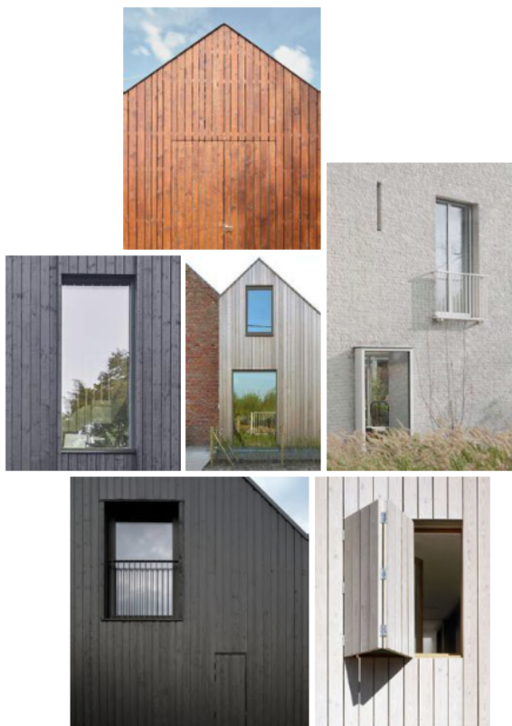
Voorbeelden van eigentijdse ingetogen gedetailleerde kozijnen.
