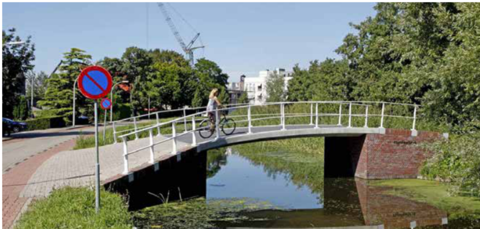
Referentie verkeersbrug met verstevigde brughoofden over de nieuwe wetering
