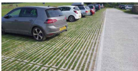
Waterdoorlatende verharding in parkeervakken
