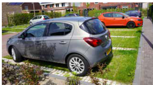
Waterdoorlatende verharding in parkeervakken
