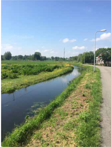
De Ringdijk ter hoogte van Ringdijk 2
