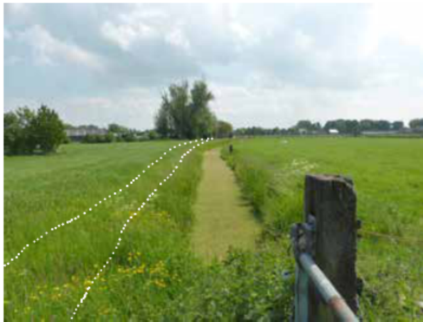
Bestaande Ringdijk met mogelijke route (linkerzijde foto)
