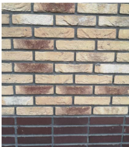
Referentie voor het materiaalgebruik: metselwerk van het huidige Kulturhus
