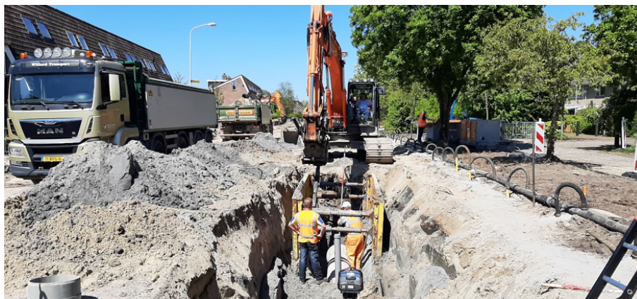
Afbeelding 6: Rioleringswerkzaamheden in bestaand gebied
