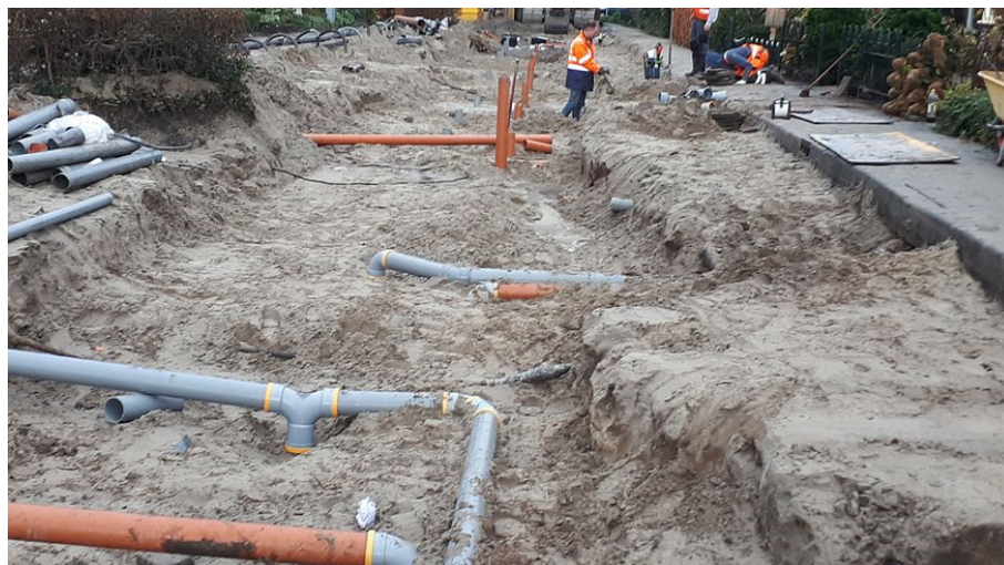
Afbeelding 5: Aanleg gescheiden riolering in De Koog, Uitgeest
