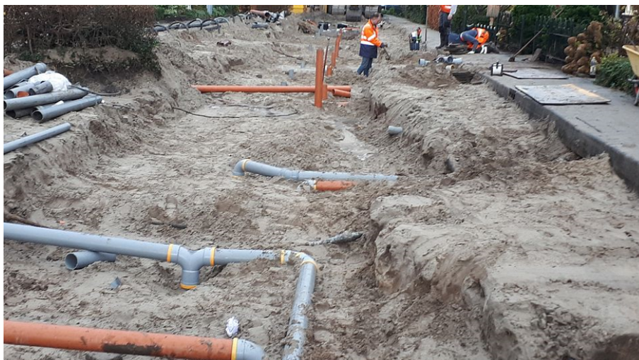
Afbeelding 5: Aanleg gescheiden riolering in De Koog, Uitgeest
