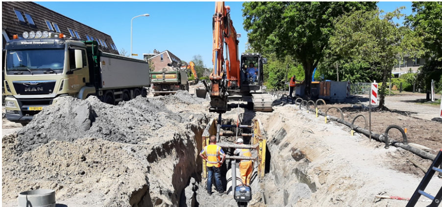
Afbeelding 6: Rioleringswerkzaamheden in bestaand gebied
