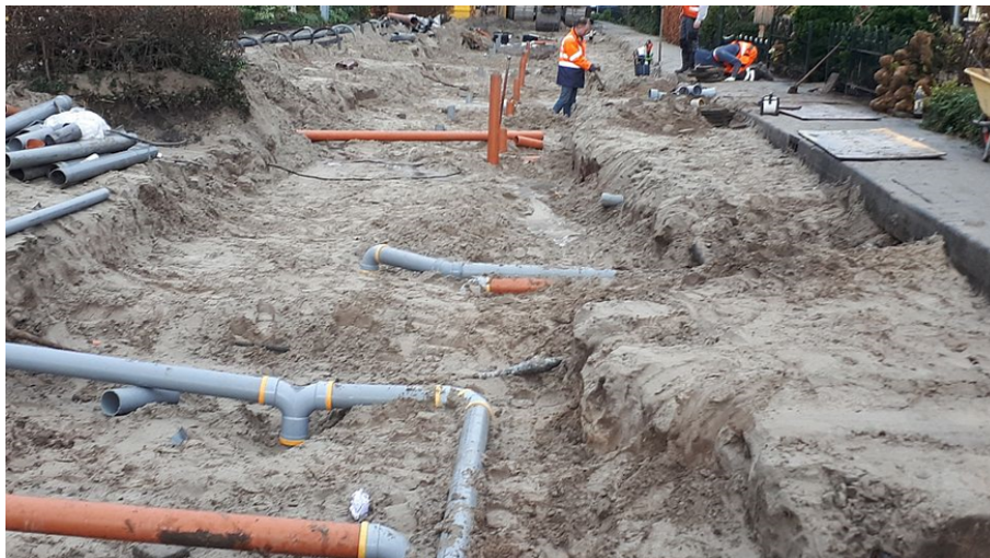
Afbeelding 5: Aanleg gescheiden riolering in De Koog, Uitgeest
