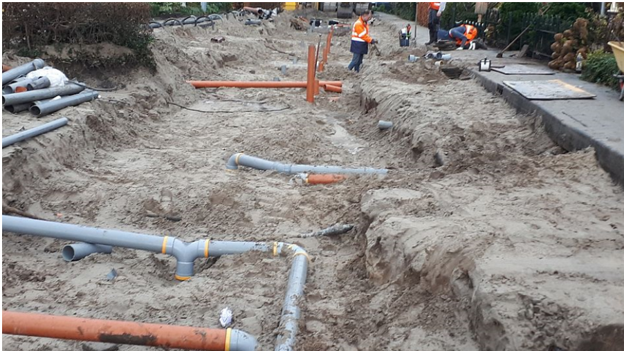
Afbeelding 5: Aanleg gescheiden riolering in De Koog, Uitgeest
