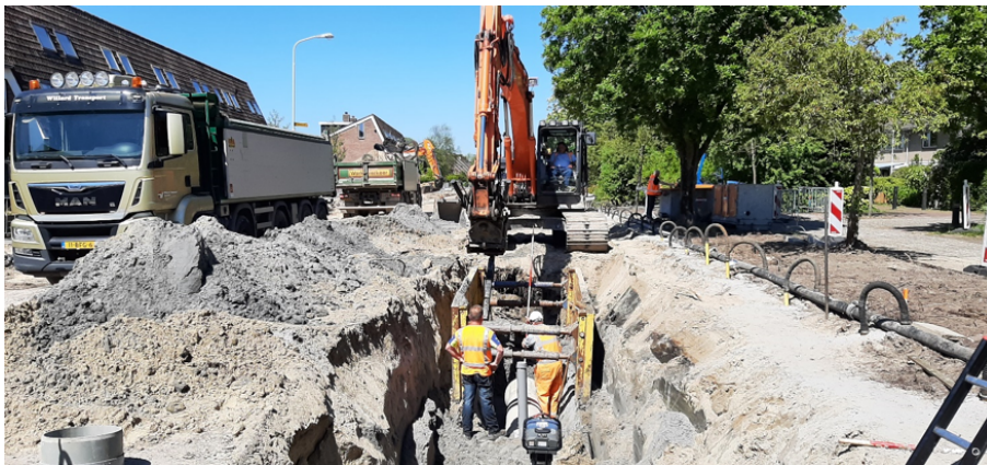
Afbeelding 6: Rioleringswerkzaamheden in bestaand gebied
