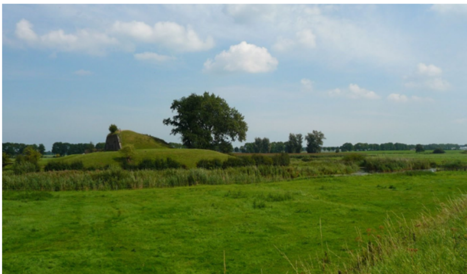
De batterij onder Poederoijen onderdeel van de NHW
