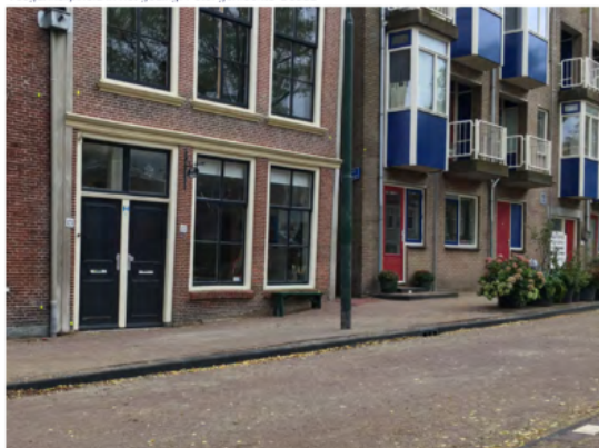
Maatwerkoplossing openbare ruimte Raam. Foto: gemeente Gouda
