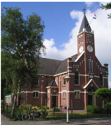
Figuur 27: Warmoltskerk (gereformeerde kerk) Harkema. Geen monumentale status (bron: Vreeman, H)
