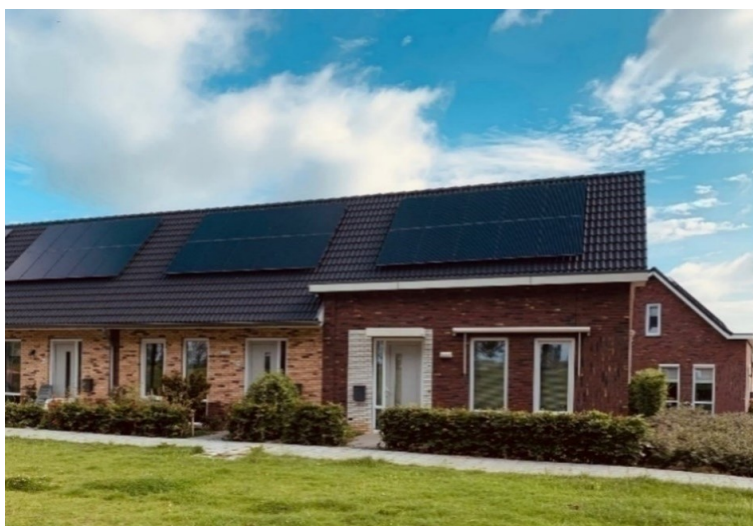
Levensloopbestendige woningen aan de Koppelweg (2020)
