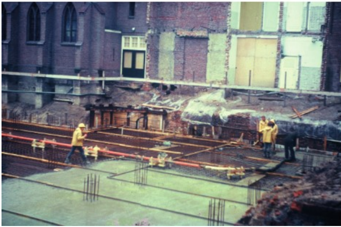
Bij werkzaamheden werd een deel van de oude muur zichtbaar. (Afb.: Marga Klompé)
