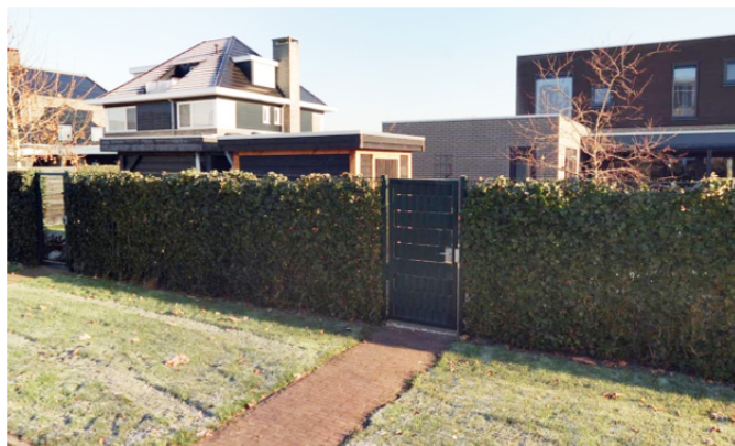
Voorbeeld Zeelt, Bornsche Maten. Eenduidigheid met hederahekwerk en poorten. Bergingen met een-zelfde daklijn en in zwarte uitvoering.
