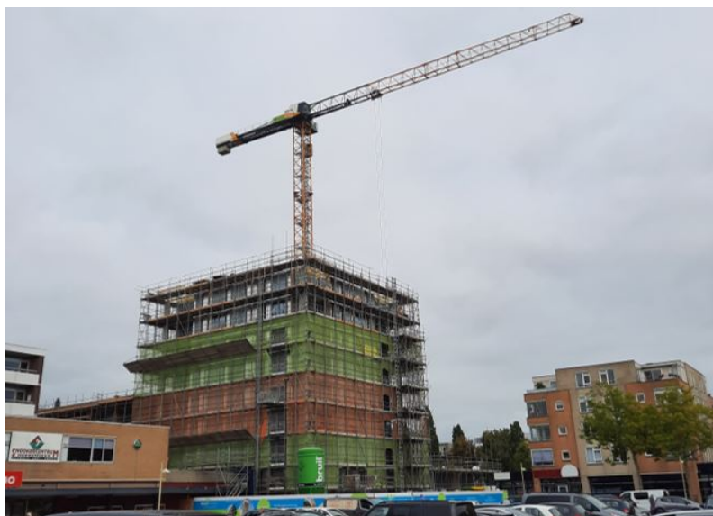
Bouw woontoren aan het Burgemeester Kuperusplein in Heerenveen.
