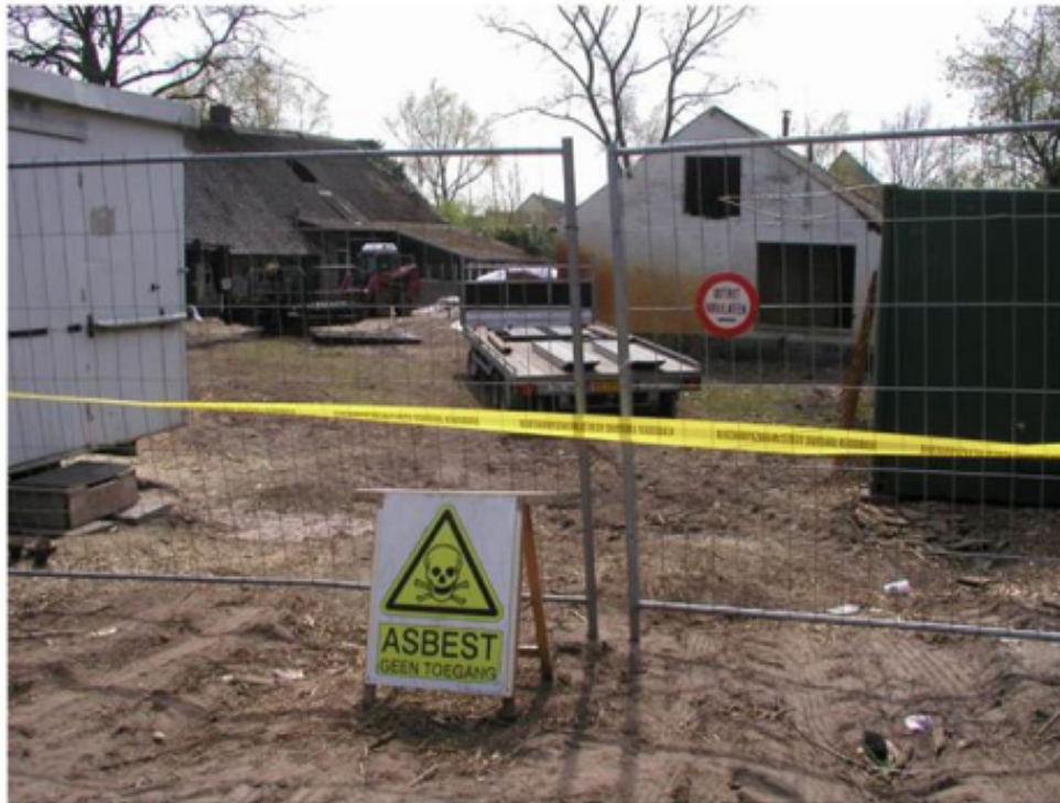
Figuur 4.11: Afscherming van een asbestverdachte locatie
