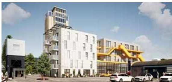
Staal, vernieuwende en betaalbare woningbouw in het Havenkwartier Deventer (bron: Buro Duck)
