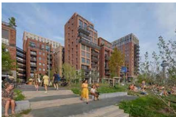
Little C Rotterdam, hoger bouwen als impuls voor transformatie van de Coolhaven tot een groene en autovrije omgeving (bron: INBO Architecten)
