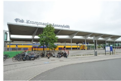
NS Station Krommenie-Assendelft
