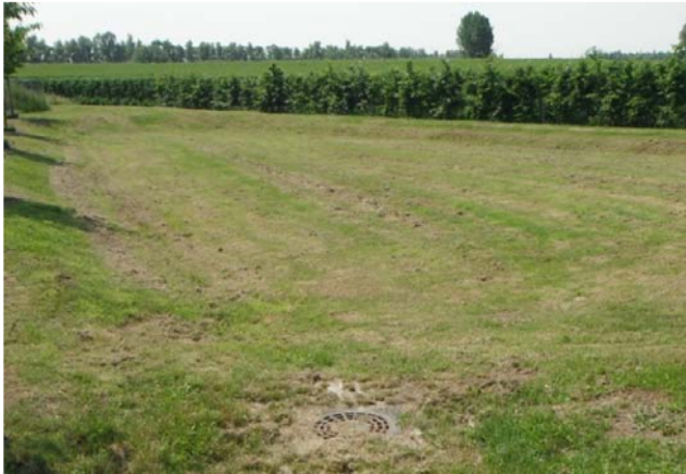
Bestaande wadi voor waterberging, retentie en infiltratie in combinatie met versterking biodiversiteit.
