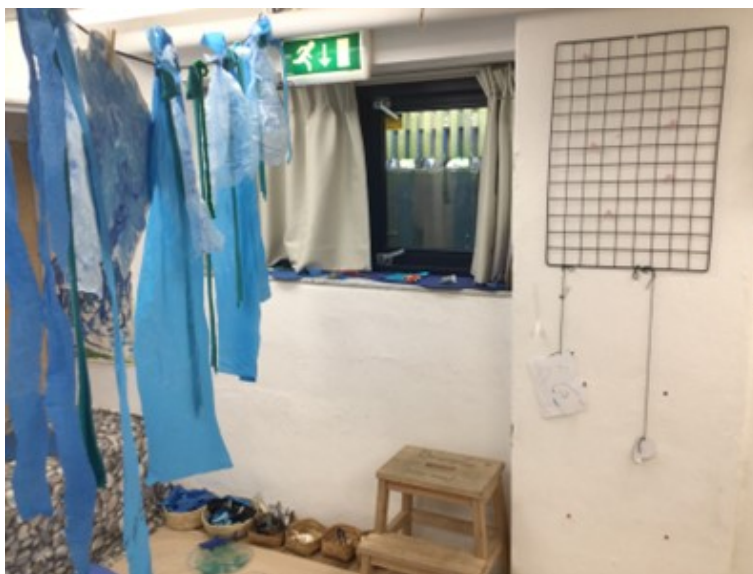
Een onverantwoorde vluchtweg die is gecreëerd door een raam met een waslijn ervoor, inclusief brandtrap en vluchtwegaanduiding.
