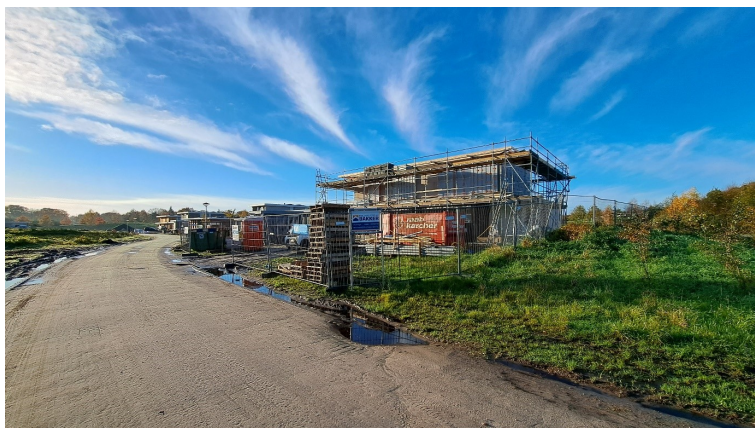
Nieuwbouw van een woning aan de Regentesselaan in Skoatterwald.
