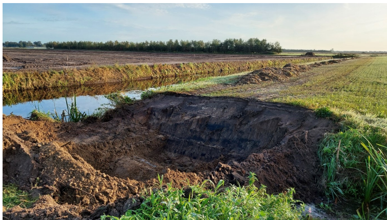
Bodemsanering van een vervuilde dam op het bedrijventerrein (in aanleg) Klaverblad Noord Oost.
