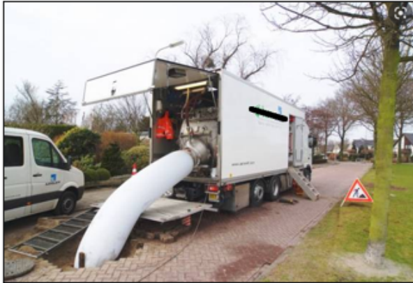
Foto 1: Er wordt een kous in het riool aangebracht ( relining )
