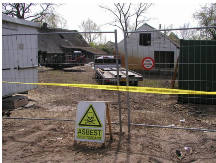
Figuur 17: Afscherming van een asbestverdachte locatie
