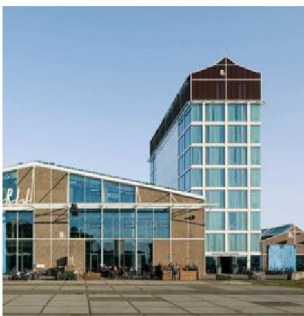
BESTAANDE LOODS ACHT VERDIEPINGEN OPGETILD
