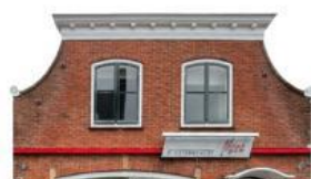
Halsegevel en getoogde houten vensters met elk vier ruiten.
