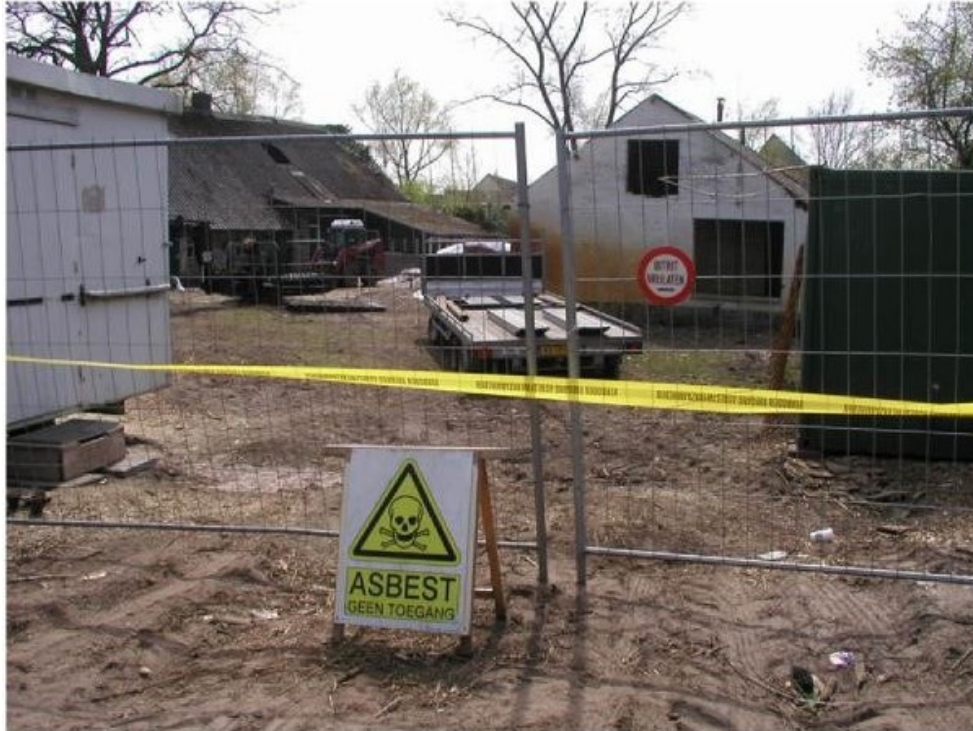
Figuur 4.11: Afscherming van een asbestverdachte locatie
