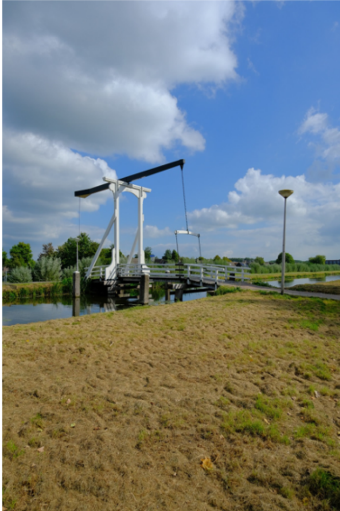
Witte Brug, Nieuwerkerk aan den IJssel
