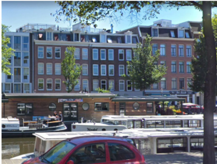
Duidelijk zichtbare dakterrassen
