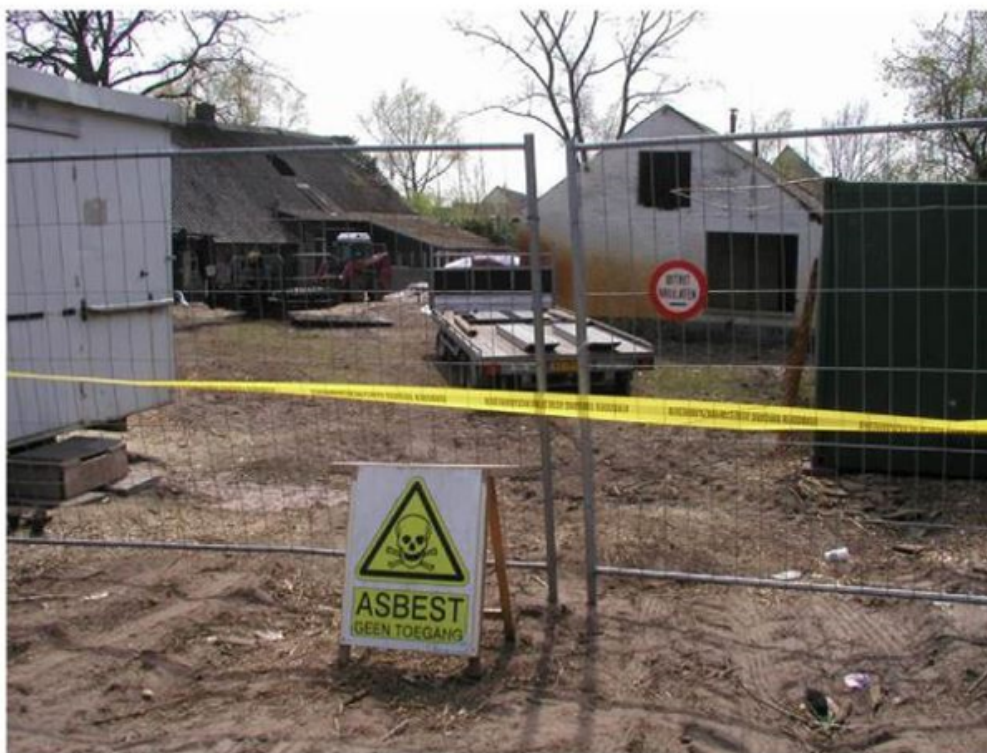
Figuur 4.11: Afscherming van een asbestverdachte locatie
