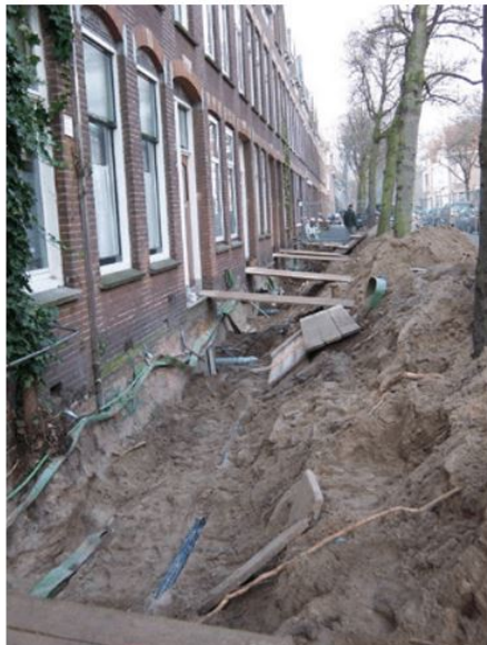
Figuur 6: Werk aan kabels en leidingen.
