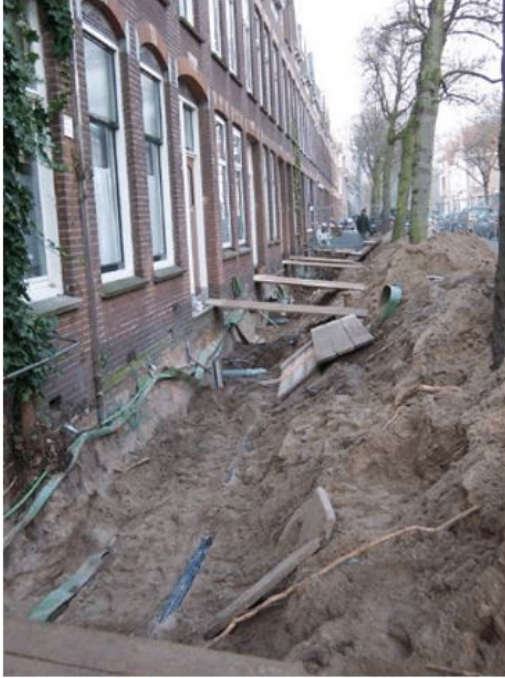
Figuur 6: Werk aan kabels en leidingen.
