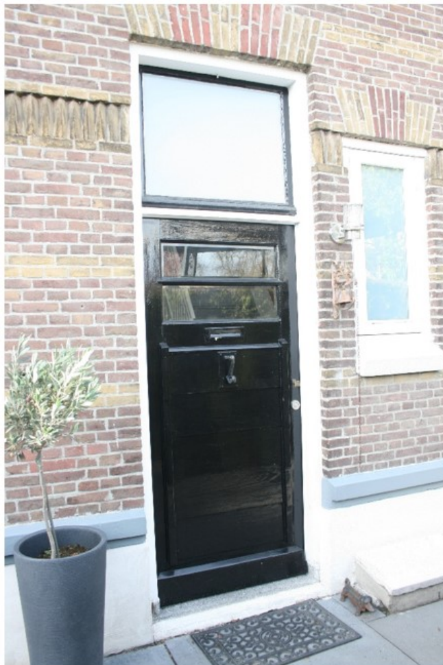
Voordeur in linkerzijgevel, rechts de kolenbak
