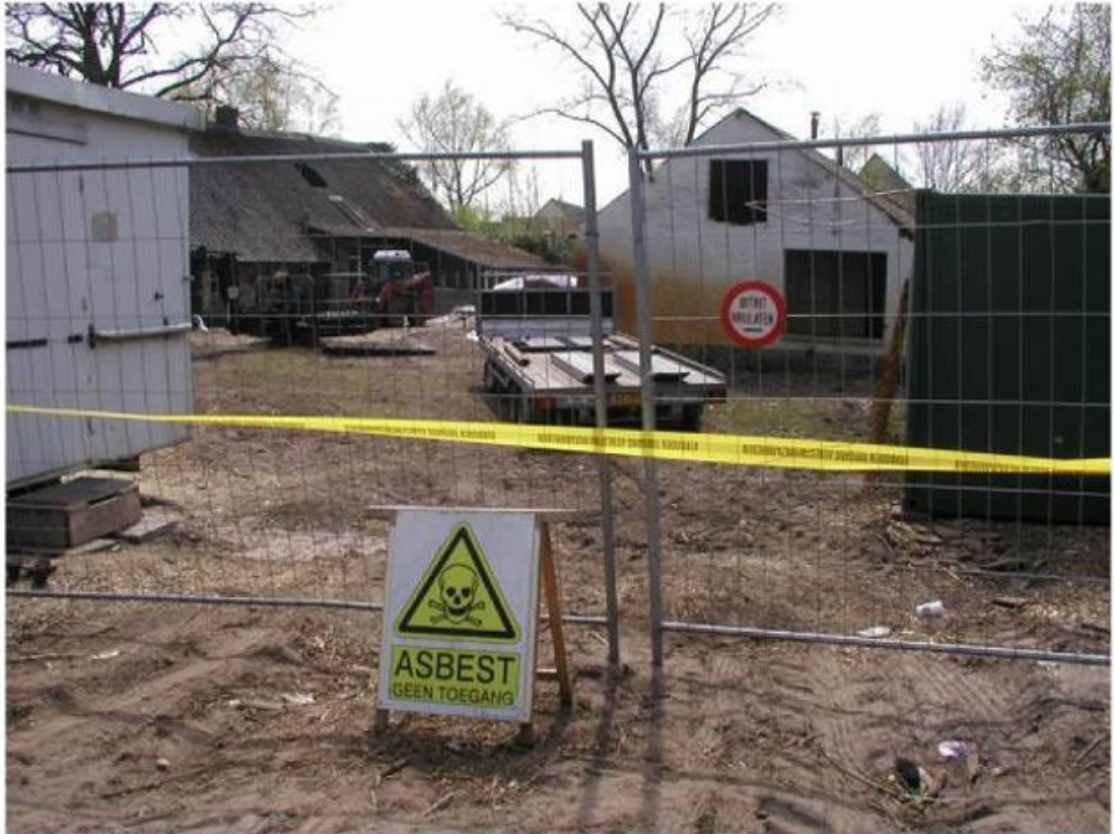
Figuur 4.11: Afscherming van een asbestverdachte locatie
