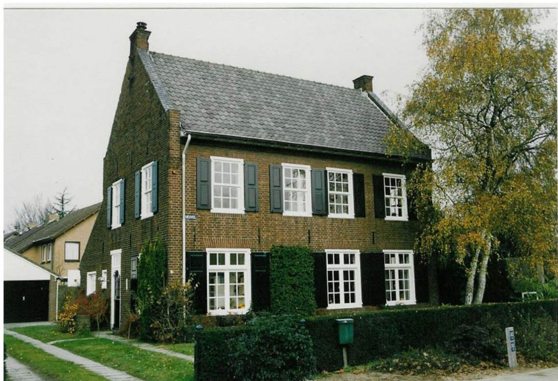
Heuvel 13 in Gerwen, woonhuis van het hoofd van de lagere katholieke school in Gerwen, in 1936 gebouwd in opdracht van het kerkbestuur (foto uit 1995, bron: Beeldbank heemkundekring De Drijehornick).
