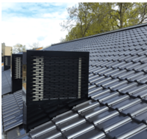
Wenselijk: buitenunits als onderdeel van de architectuur.
