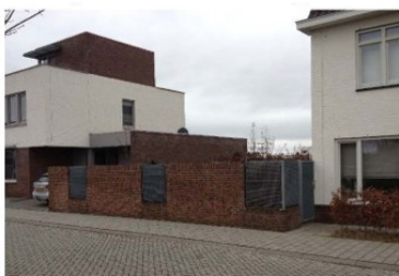
Metselwerk gecombineerd met metalen rasters
