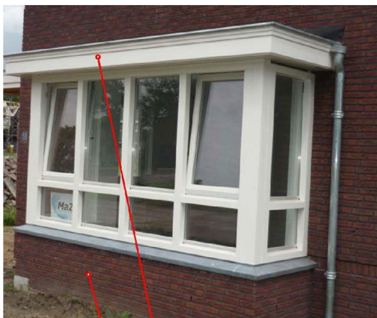
Borstwering in metselwerk.
