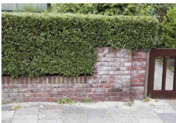
Metselwerk gecombineerd met begroeiing
