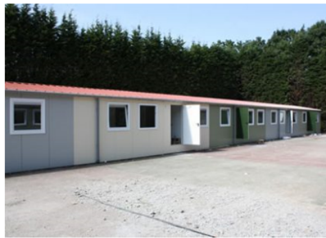
Wooncomplex Jobcenter in Den Haag Voorbeeld van onaantrekkelijk vormgegeven woonentrees
