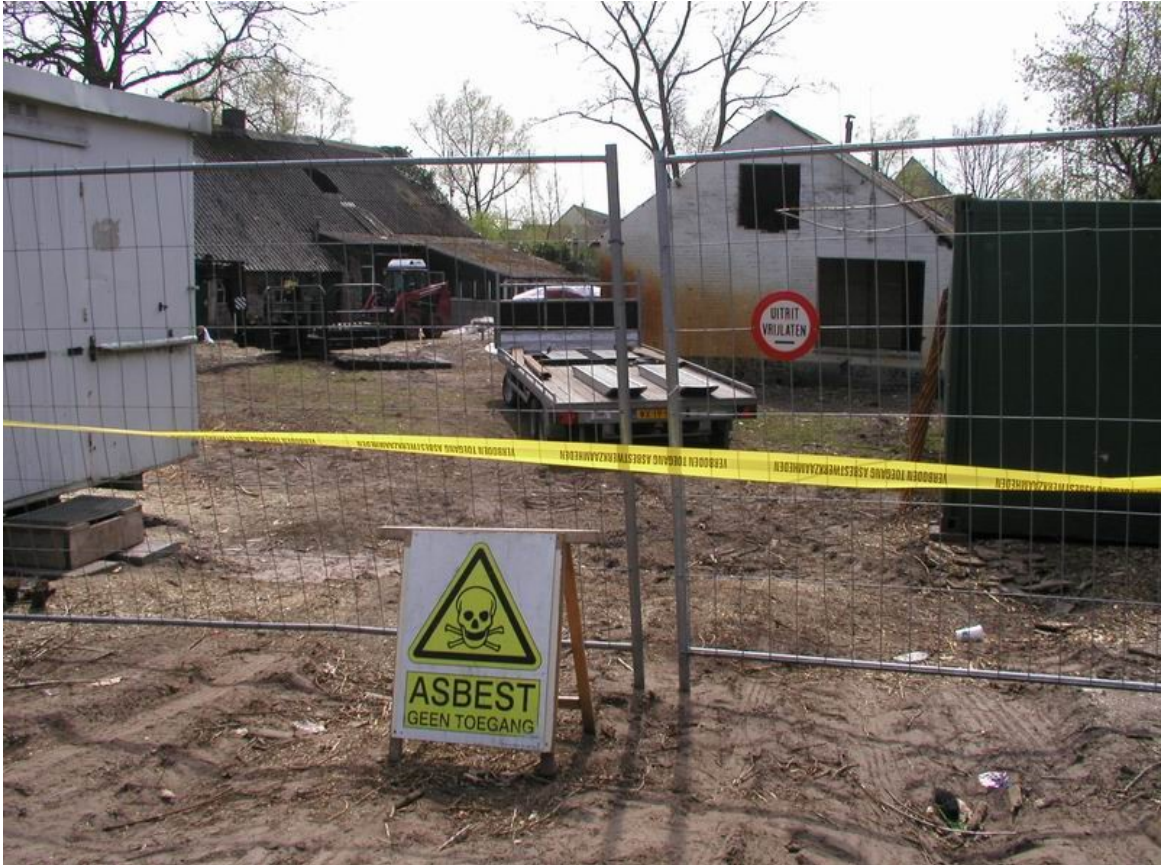
Figuur 17: Afscherming van een asbestverdachte locatie Wanneer is asbestonderzoek verplicht?
