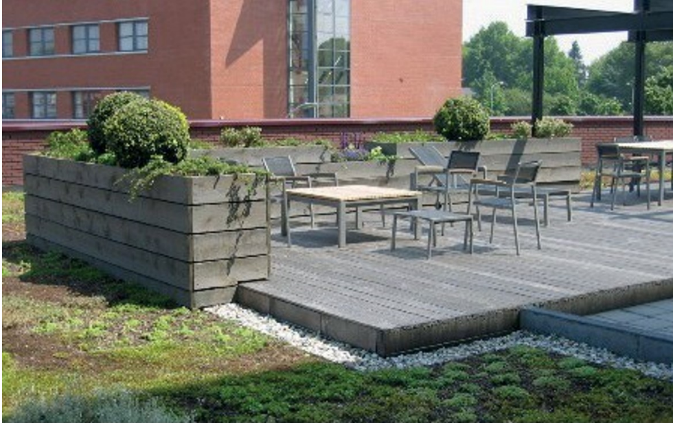
Sedumdak met verhoogde dakrand
