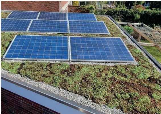
Parkeren onder sedumdak met zonnepanelen
