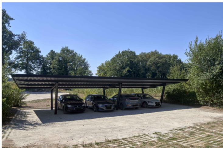
Figuur 4: zonnepanelen als overkapping parke-ren © HILBERINKBOSCH architecten
