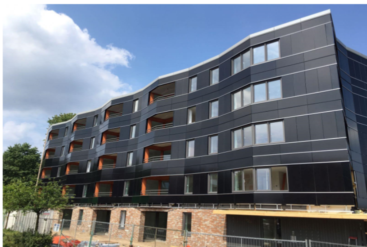
Figuur 1: zonnepanelen in gevels © eigenenergie.net
