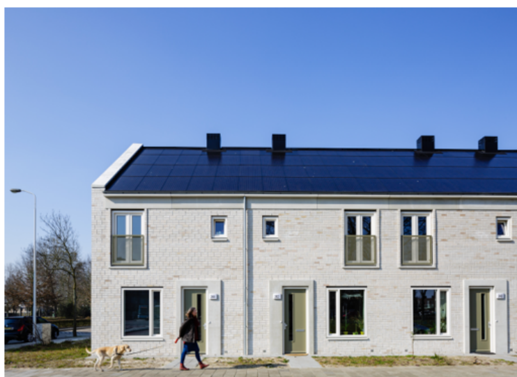
Figuur 2: zonnepanelen geïntegreerd in daken © BASE
