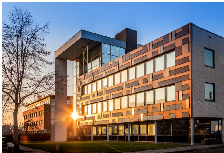
Figuur 5: zonnepanelen in de gevel © Solarix
