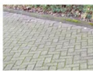
bestaande weg vanaf Schraaierstraat naar parkeerterrein
