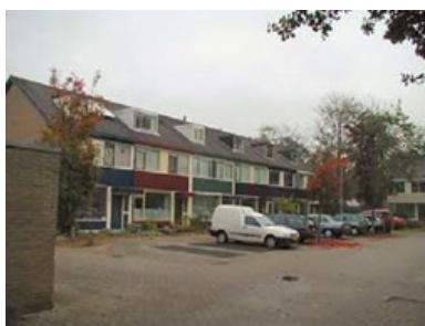
Rijtjeswoningen met verschillende dakkapellen in Couwenhoven
