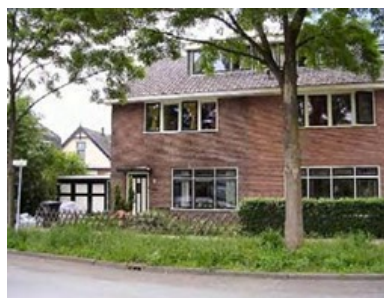
Vooroorlogse middenstandsvilla's aan de Koppelweg.
