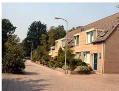
Nieuwbouw rijtjeswoningen aan de Willen Versteeghstraat.
