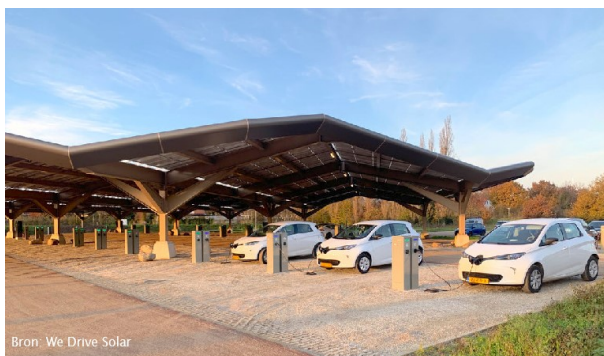
Afbeelding 3.64 Voorbeeld laadplein met zonnepanelen Triodos Bank
