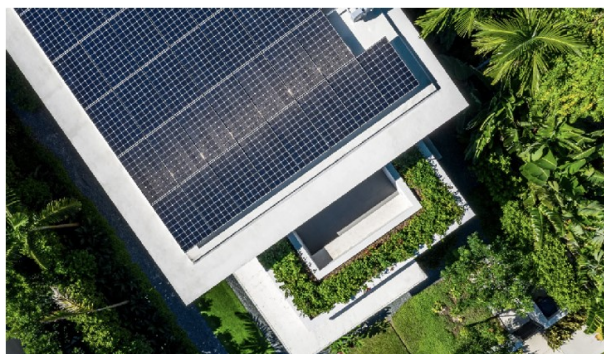
Afbeelding 4.2 - Integratie duurzame energie en CO2 neutraal bouwen
