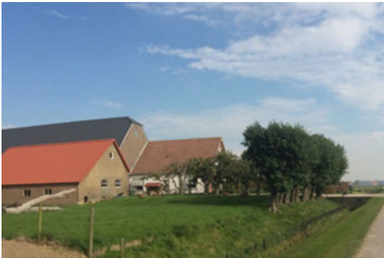
Nieuwe schuren en bijgebouwen vormen een ensemble met het hoofgebouw
