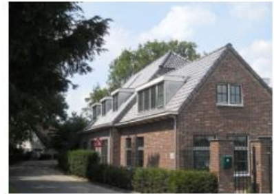
De richting van de hoofd- en bijgebouwen is evenwijdig aan de dijk
