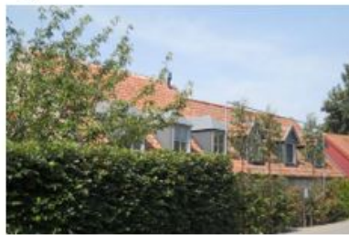
De bebouwing heeft één bouwlaag met kap- ten opzichte van het dijkniveau.
