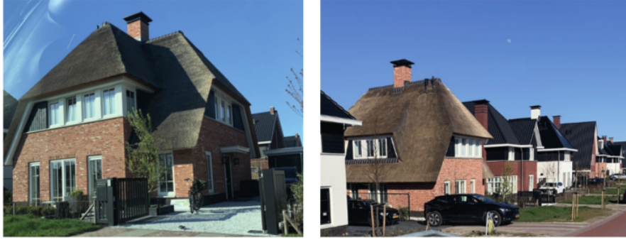
Een woning zoals in het sfeerbeeld hierboven is gewenst door de toekomstige bewoner. De woning heeft een overheersend lage goot en vormt daarmee een mooie overgang naar de bouwhoogtes aan de Heuvelstraat. Het gebouw heeft twee kaprichtingen en sluit daarmee ook aan op de buurwoning. (Eve architecten)
