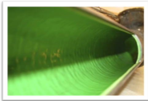
Rioolbuis voorzien van nieuwe binnenkant d.m.v. relinen.
