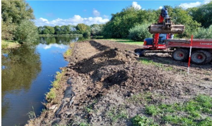
De aanleg van natuurvriendelijke oevers in het Westerpark.
