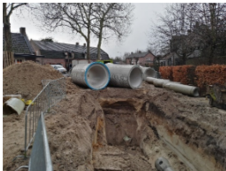
Figuur 6: Realisatie riolering Oostrikkerstraat
