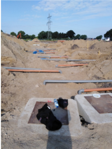
Figuur 10: Aanleg huisuitleggers De Bulders
