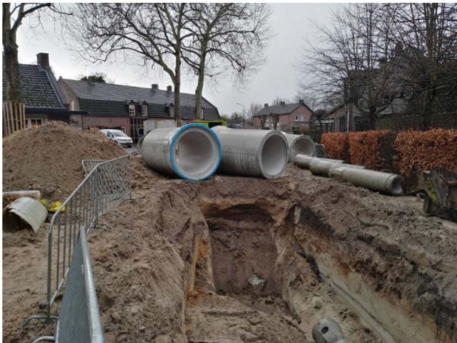
Figuur 8: Aanleg riolering Oosterikkerstraat in Leende
