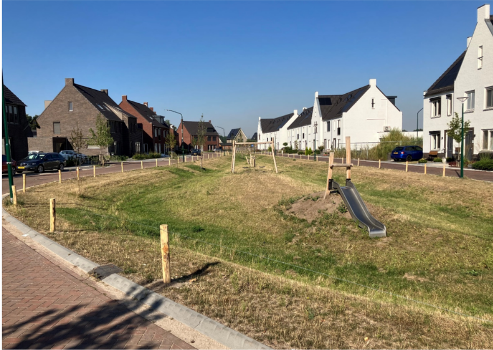
Figuur 1: Dubbelfunctie wadi en speeltoestellen Bulders Schaverspad
