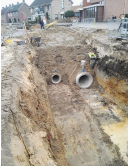
Figuur 7: Gescheiden rioolstelsel Spoorlaan - Schoolstraat
