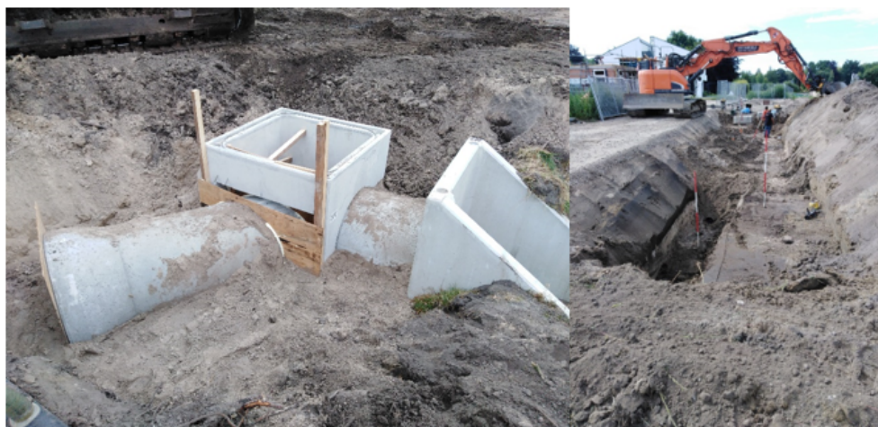
Figuur 12: Aanleg riolering De Bulders
