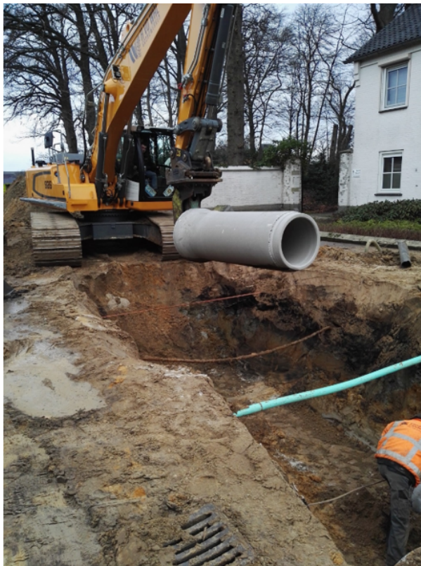
Figuur 21: Aanleg riolering Spoorlaan Schoolstraat
