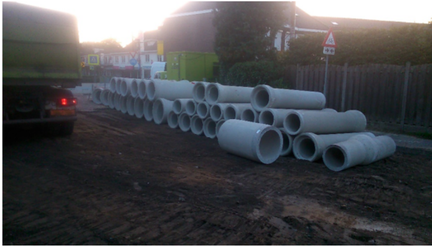
Figuur 20: Aanleg riolering Stationstraat in Heeze
