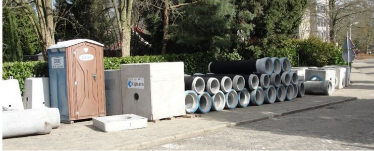
Infiltratietransportriolen in Dorrestein voor de ombouw van gemengd riool naar gescheiden riool, waarbij het afstromend regenwater zo veel mogelijk in de bodem wordt geïnfilteerd
