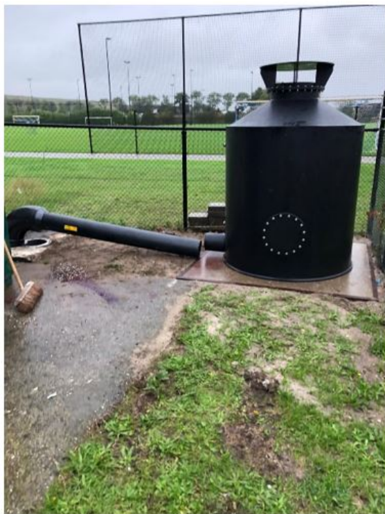
Vervangen van het geurfilter bij hoofdgemaal Vathorst, juli 2020
