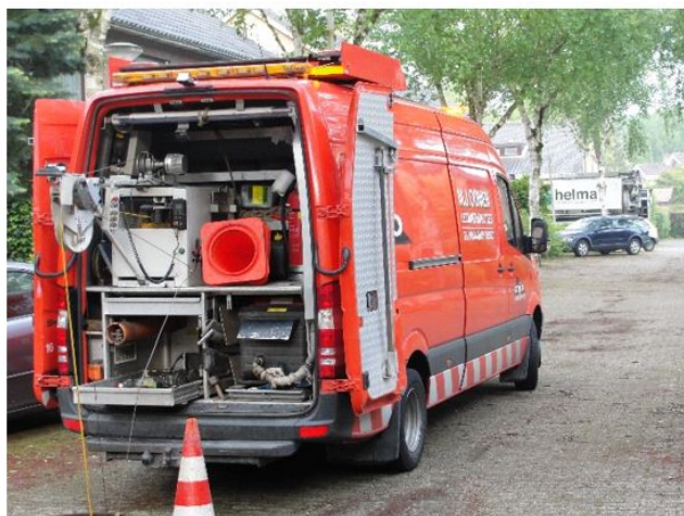
Camera inspectie van riolen
