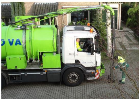
Reiniging van straatkolken door de ROVA
