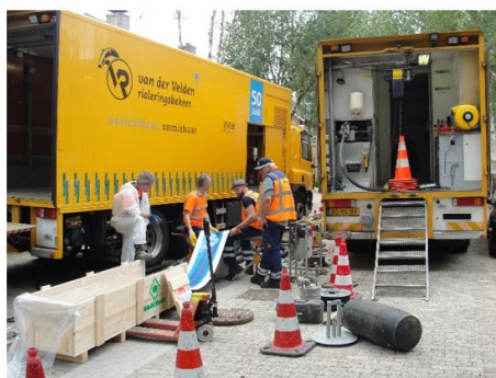
Relinen riolen; kunststof kous wordt in riool gebracht
