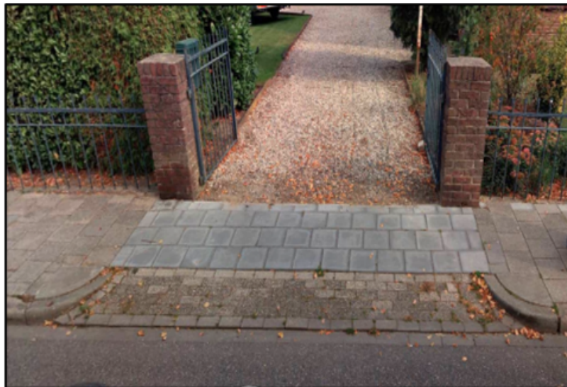
Figuur F: voorbeeld uitwegconstructie
