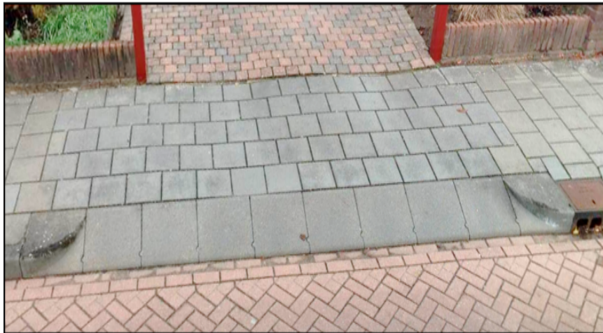
Figuur D: voorbeeld uitwegconstructie
