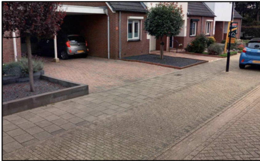
Figuur G: voorbeeld uitwegconstructie
