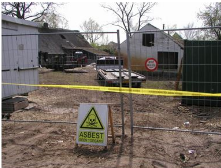
Figuur 17: Afscherming van een asbestverdachte locatie
