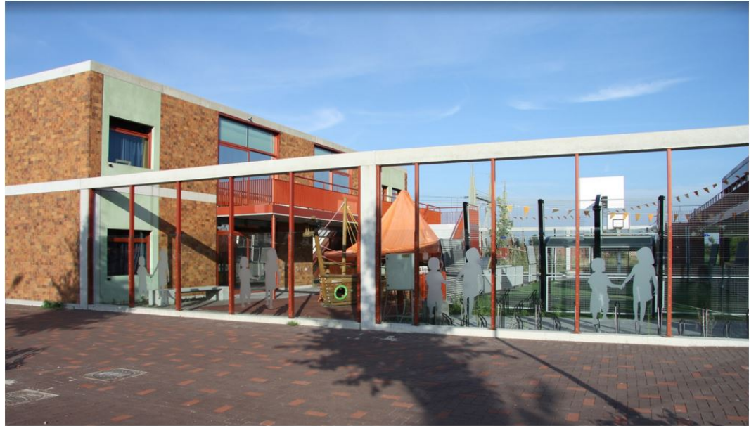
figuur 7 Glazen afscherming voor een geluidsluwe binnenplaats
