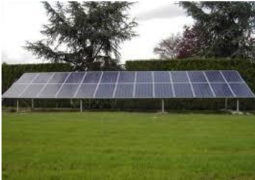
Afbeelding 3; 2 meter hoge grondopstelling voor tussen percelen
